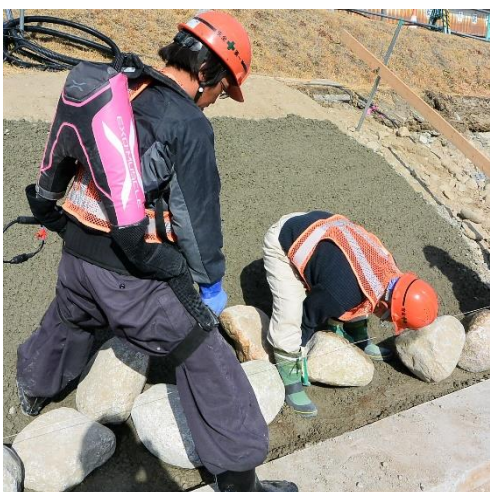
作業③：ランダムに並べられた石を、石工と呼ばれる石職人が高さや平らになるように並べていく。最終的に堤防が平らに出来上がるかどうかはこの石工の腕次第。
