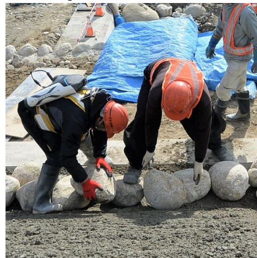
作業②：重機から降ろした石を持ち上げたり、中腰姿勢で転がして配置調整を行う。マッスルスーツ®がこの作業をサポートして身体の負担を軽減する。
